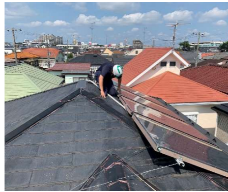
雨漏りにより腐食した出窓庇
